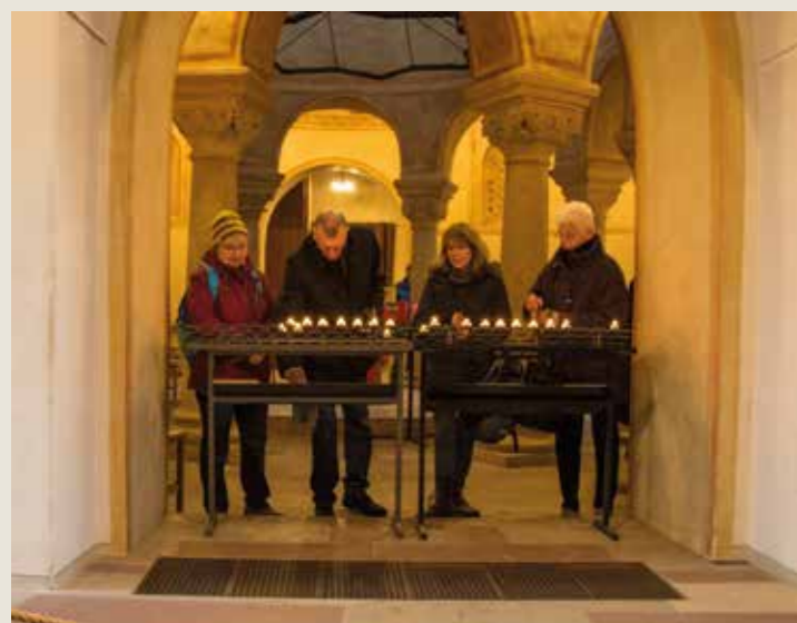
Besucher in St. Michael; im Vordergrund ein Gitter der Luftheizungsanlage.
