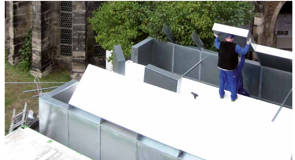
Erstellung der Schalldämmhaube im Bereich des vorhandenen Kühlcontainers, in dem wertvolle Funde einer ersten Untersuchung unterzogen werden.
