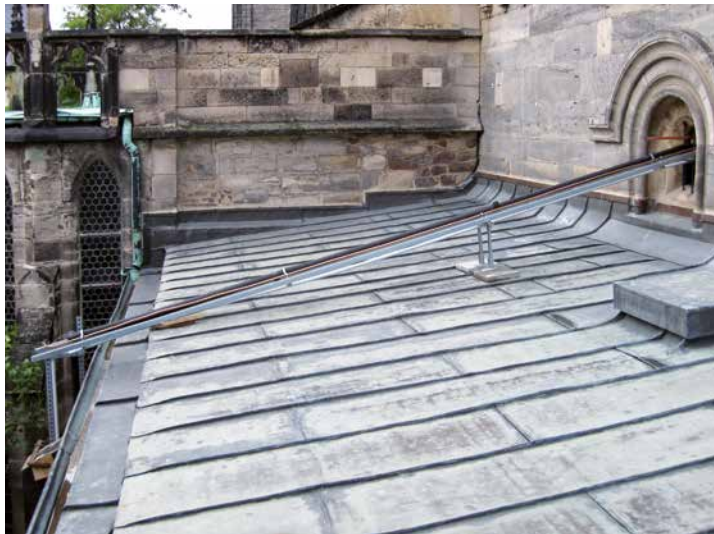
Die Versorgungsleitungen mussten teilweise mit „viel Phantasie“ verlegt werden, da Befestigungen am Mauerwerk nicht zulässig waren.
