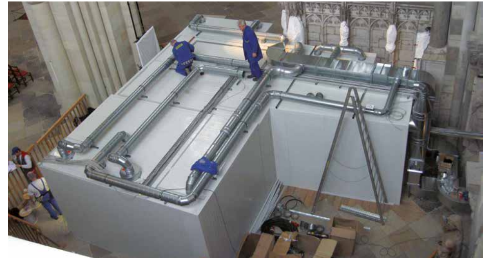
Die bereits erstellte Klimakammer während der Luftkanalmontage.
