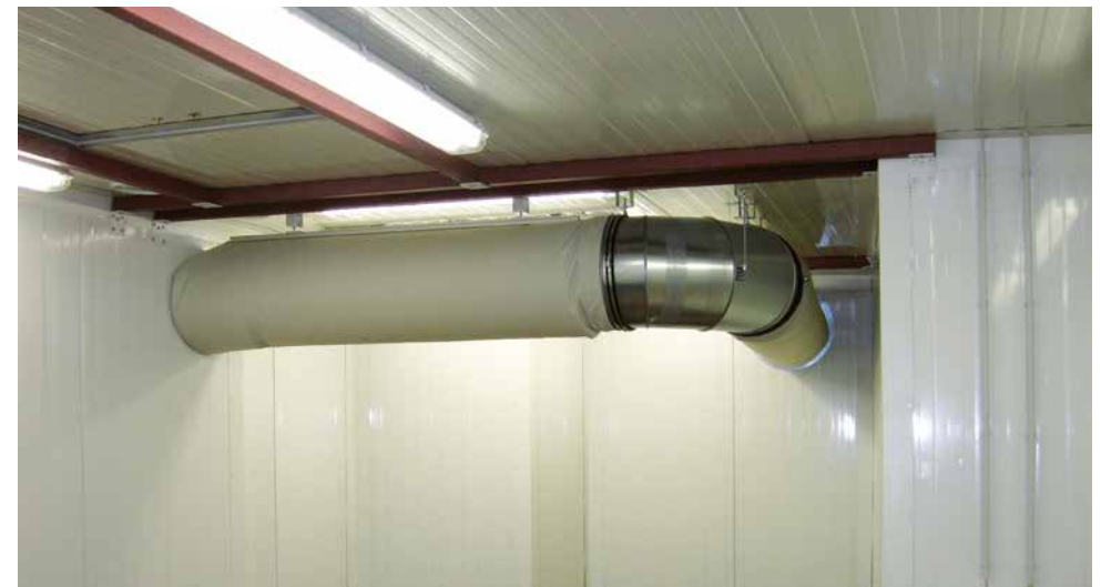
Textilauslässe innerhalb der Kammer, über die eine möglichst zugfreie und gleichmäßige Klimatisierung der Kammer erreicht wurde.
