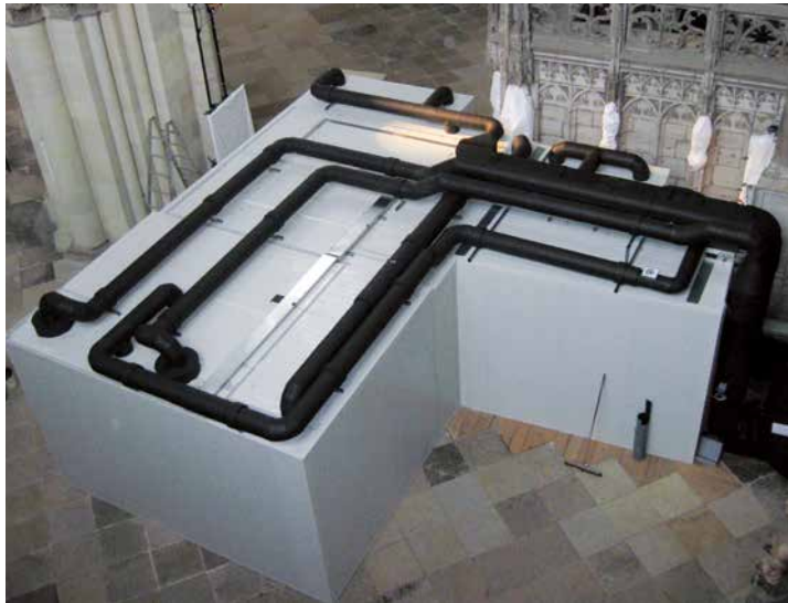
Fertige Kammer mit gedämmten Kanälen.
